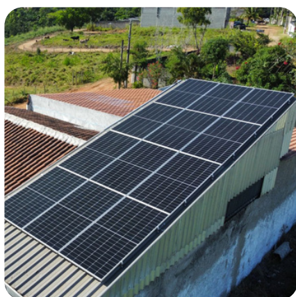
Projeto Residencial 6,54kWp - 12 Módulos Serra - ES
