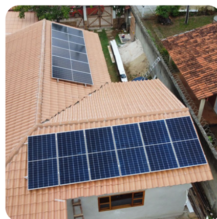
Projeto Residencial 6,48kWp - 12 Módulos Guarapari- ES
