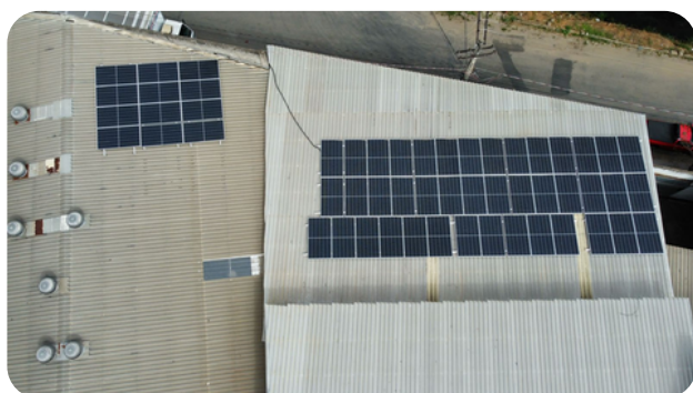
Projeto Industrial 27,00 kWp - 54 Módulos Cariacica - ES
