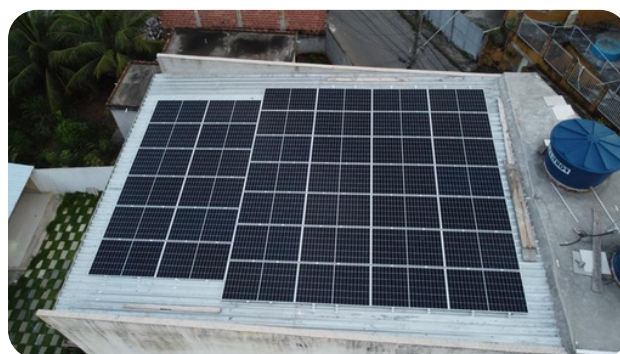
Projeto Residencial 15,00kWp - 40 Módulos Serra - ES
